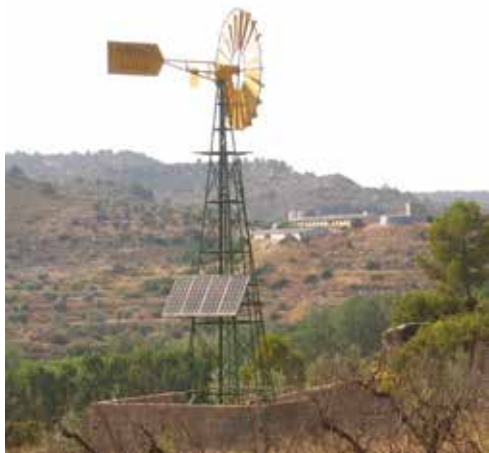
Molino de viento para extracción de agua.
