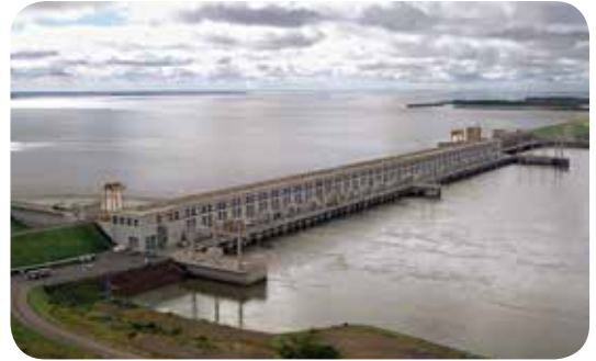
Vista externa desde el margen derecho de la central Hidroeléctrica Yaciretá, sobre el río Paraná.
