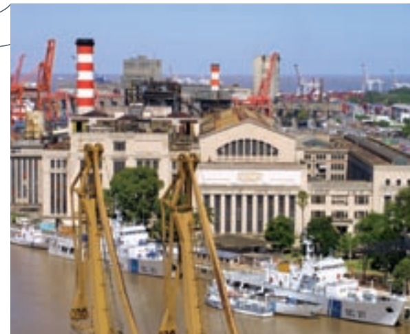
La central termoeléctrica de Puerto Nuevo se encuentra en la Ciudad Autónoma de Buenos Aires.
