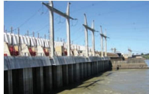
La central hidroeléctrica de Salto Grande, sobre el río Uruguay, está ubicada a unos 15 kilómetros al norte de la ciudad entrerriana de Concordia. Se encuentra en funcionamiento desde 1979.
