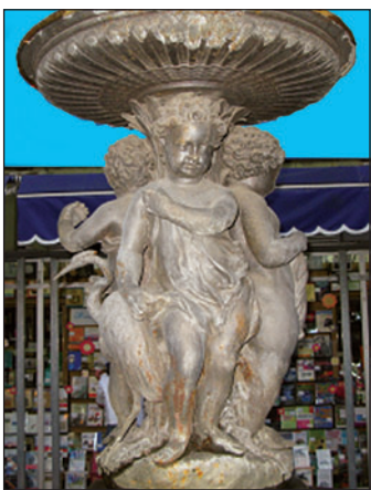
Figura 1.2. Corrosión de una estatua metálica. Córdoba, Argentina.
