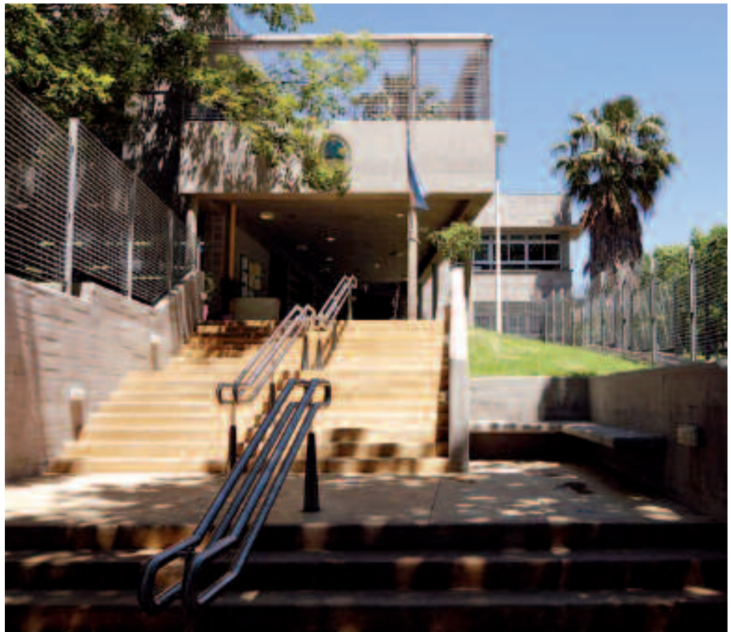
Jardín de Infantes en el hospital Parmenio Piñero GCABA. Acceso: lugar de transición entre la ciudad y el Jardín. Escalinata y rampas definen el borde entre el Jardín y el parque del Hospital. Foto: Alejandro Leveratto
