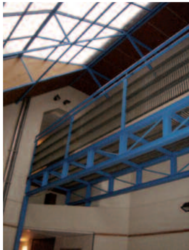
Escuela Secundaria Ecos CABA. El puente conecta, el puente exhibe. Foto: Archivo CHD arquitectos
