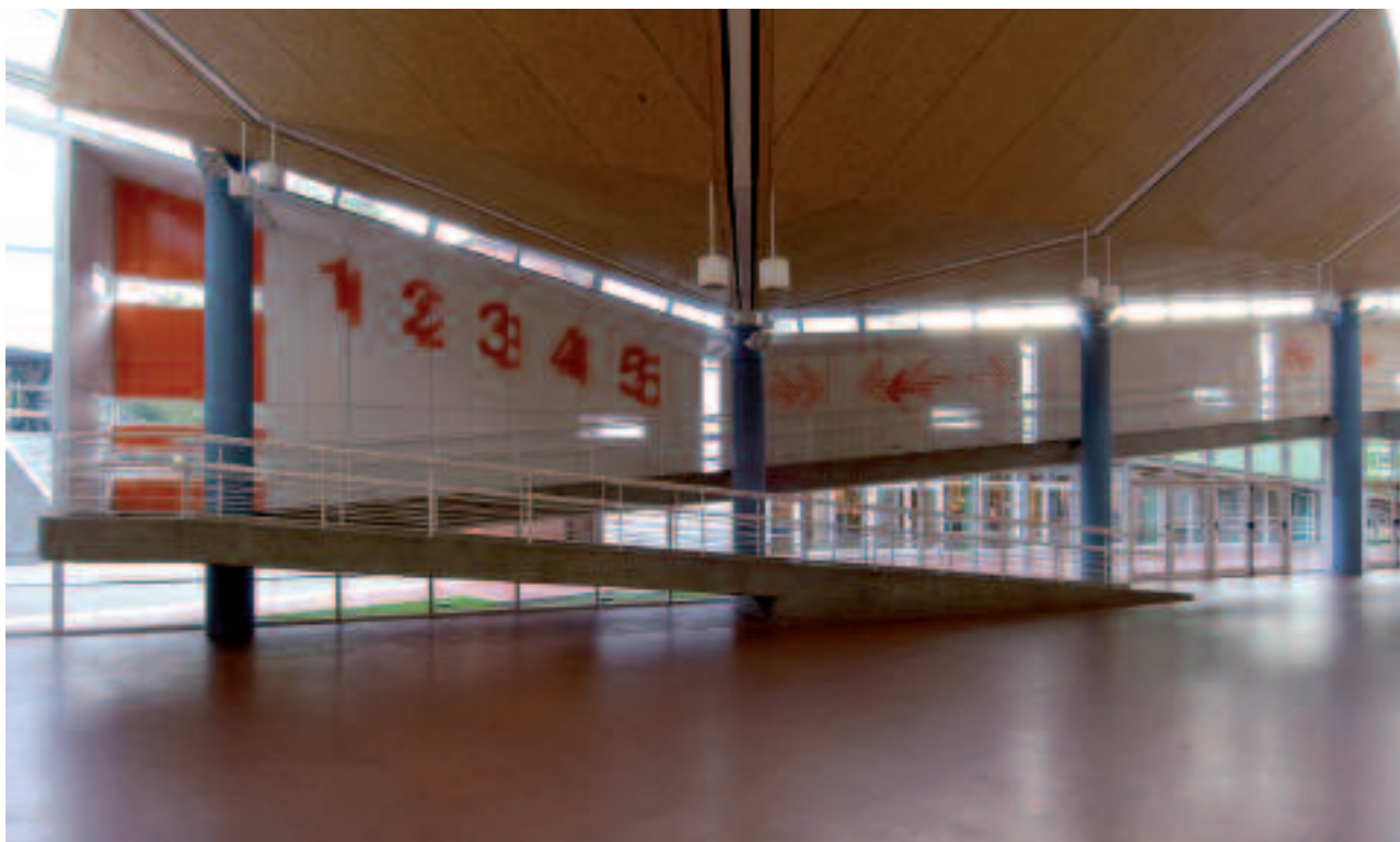
Jardín de Infantes y EGB 1 Colegio Goethe. San Isidro Provincia de Buenos Aires. Autores de la obra Misgisisisi Arquitectos. Rampa de suave pendiente: "promenade" en el Jardín de infantes. Foto: Daniela Mac Adeen
