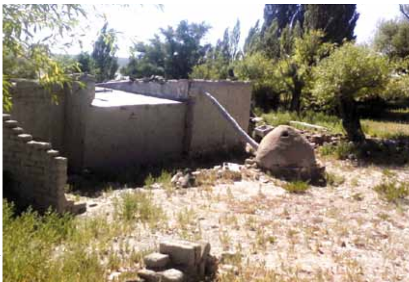
Vivienda rural de adobe en la comunidad mapuche-tehuelche Caltrauna.
