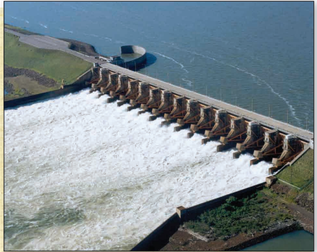
Central hidroeléctrica Yacyretá.
