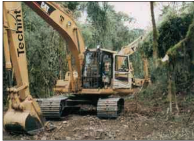
Máquinas desmontando la selva para instalar la tubería.
