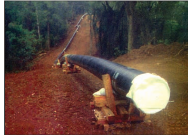
Los tubos preparados para ser instalados.
