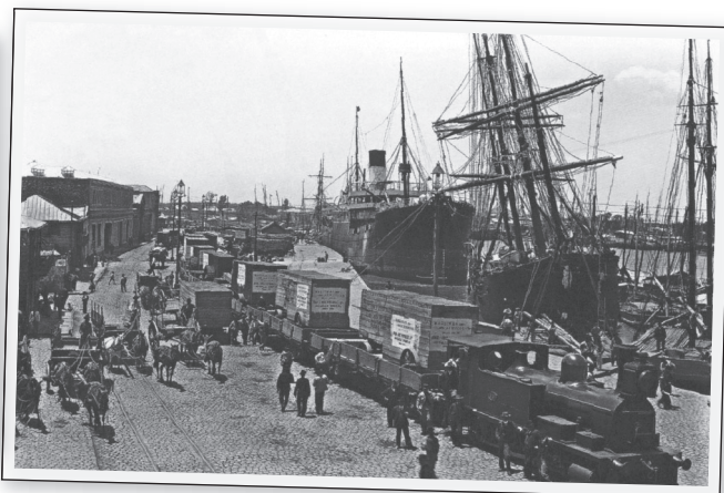
El ferrocarril en la Argentina agroexportadora de comienzos del siglo XX conectaba las regiones productivas con los puertos para la exportación de materias primas.
