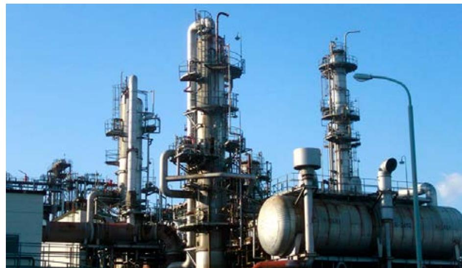
Sistema de destilación de una planta industrial. Las columnas que se ven son los condensadores del sistema (columnas de fraccionamiento) y los tanques contienen la mezcla que se quiere fraccionar.
