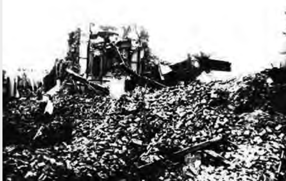
Figura 14. Daños en una Iglesia de San Juan. Terremoto del 15 de enero de 1944.
