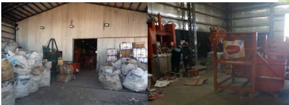
Figura 42: Planta de tratamiento de residuos de Viedma (Río Negro)
